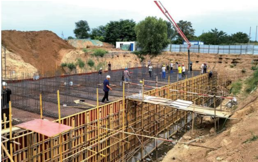
项目建设中（乏风换热水池泵房）
