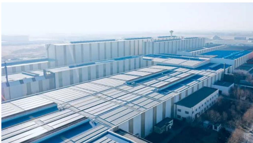
针对漏水屋顶,天诚同创创新地采用 BIPV(光伏建筑一体化)技术,在 2 万平方米厂房上建设 2MW 容量 BIPV 项目,满足屋顶更换和绿色电力的双重需求。在未来 25 年的项目周期内,冷轧薄板公司将不用更换屋顶,按目前使用的宝钢双层彩钢进行测算,可节约彩钢屋顶更换及维护费用超 1500 万元。
